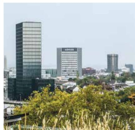
Der Grosspeter Tower ist das erste Hochhaus mit voll integrierter Photovoltaik-Fassade. Die visuelle Ästhetik der Fassaden lässt auf den ersten Blick nicht vermuten, dass die komplette Fassade aus Solarzellen zur Stromerzeugung besteht. Bodensonden ermöglichen eine Speicherung der Abwärme im Sommer für die Heizung im Winter und umgekehrt wird die Kälte im Winter zur Kühlung im Sommer gespeichert. Ein vorbildlicher Ansatz, wie ein Hochhaus als Kraftwerk genutzt werden kann.
