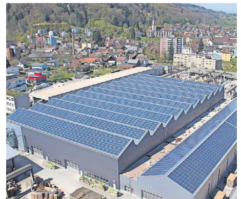
Xaver Meyer AG in Villmergen: Eines der 100 ADEV-Kraftwerke. ZVG
